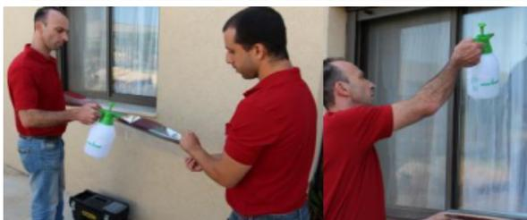
**Alternative zu Schritt 7** - Lösen Sie das Trägermaterial von der zugeschnittenen Folie (aufgewickelt mit dem Trägermaterial nach außen) und besprühen Sie die freigelegte Klebstoffschicht mit reichlich Benetzungslösung. Achten Sie darauf, dass das Fenster nass ist (mit Benetzungslösung).
