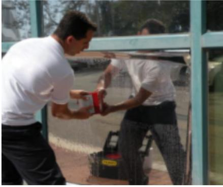
**Schritt 9** - Ziehen Sie einen robusten 6" Sicherheitsfolienraker von der Mitte mit festen Bewegungen nach unten und außen, um Wasser und Luftschlüsse herauszudrücken, die sich zwischen der Folie und dem Glas befinden.
