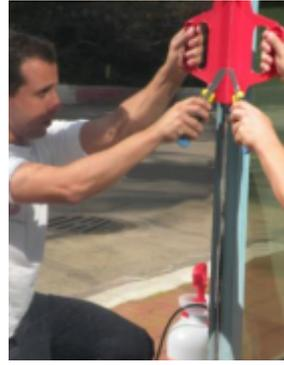
**Schritt 10** - Schneiden Sie die Kanten der Folie dicht am Fensterrahmen mit einem OLFA Messer und dem Edge Tool zu.
