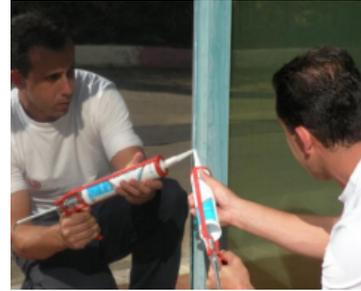
**Schritt 14 - Kantenversiegelung:** Lassen Sie die Folie 24 Stunden trocknen und führen Sie dann innerhalb von 72 Stunden auf allen vier Seiten die Kantenversiegelung durch.
