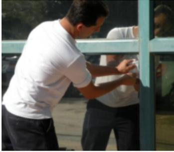
**Schritt 13** - Wischen Sie die Kanten der Folie und das Fenster trocken, verwenden Sie dazu eine mit Papiertuch umwickelte Karte.
