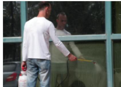
**Schritt 4 - Folie befeuchten:** Besprühen Sie die Folie auf beiden Seiten, damit sie sich nicht statisch auflädt (sonst zieht sie beim Verkleben Schmutzpartikel an) und glätten Sie sie.
