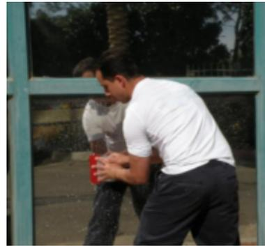
**Schritt 12**- Befeuchten Sie die Folienoberfläche abermals und arbeiten Sie nochmals mit festen Rakelstrichen von der Mitte her, um wirklich alle Luftschlüsse und Wasserreste herauszupressen.
