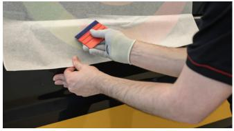
Verwenden Sie Application Paper 300 - High Tack, um eine bedruckte reflektierende V-4000-Beschriftung anzubringen
