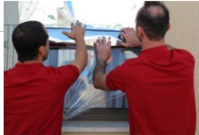
**Alternative zu Schritt 7** - Lösen Sie das Trägermaterial von der zugeschnittenen Folie (aufgewickelt mit dem Trägermaterial nach außen) und besprühen Sie die freigelegte Klebstoffschicht mit reichlich Benetzungslösung. Achten Sie darauf, dass das Fenster nass ist (mit Benetzungslösung).
