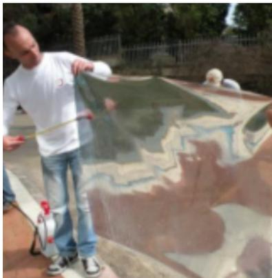
**Schritt 7** - Lösen Sie das Trägermaterial von der Folie und besprühen Sie die Klebstoffschicht mit reichlich Benetzungslösung.
