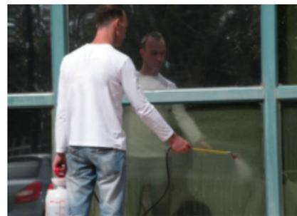
**Schritt 4 - Folie befeuchten:** Besprühen Sie die Folie auf beiden Seiten, damit sie sich nicht statisch
