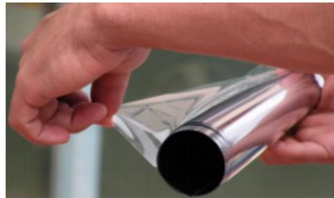
**Schritt 3 - Schneiden Sie die Folie zu:** Schneiden Sie die Folie vorab auf Fenstergröße zu und achten Sie auf eine Überlappung von 2 cm an allen vier Seiten: Arbeiten Sie direkt von der Rolle und schneiden Sie sie auf der beschichteten Seite mit einer OLFA® Klinge zu. Bei der aufgerollten Folie muss die Seite des Trägermaterials nach außen, die beschichtete Seite nach innen zeigen.
