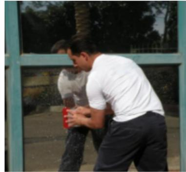
**Schritt 12**- Befeuchten Sie die Folienoberfläche abermals und arbeiten Sie nochmals mit festen Rakelstrichen von der Mitte her, um wirklich alle Luftfeinschlüsse und Wasserreste herauszupressen.
