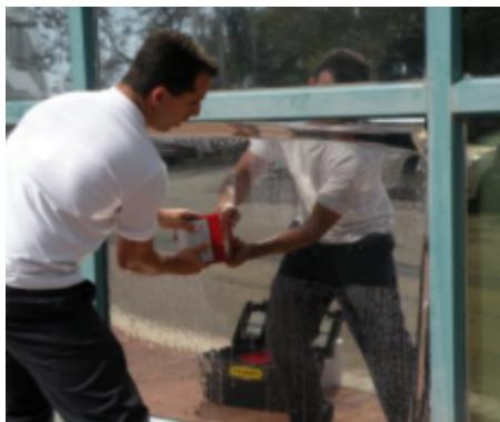
**Paso 9** - Deslice una espátula rígida de 6" desde el centro con movimientos firmes hacia abajo y hacia fuera, para eliminar las burbujas de aire y agua que hayan quedado entre el film y el cristal.
