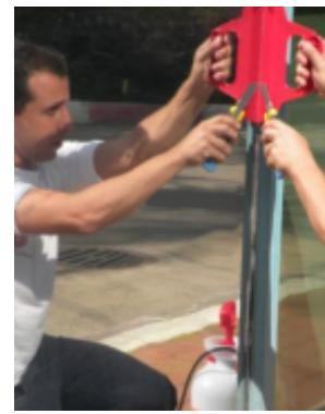
**Paso 10** - Recorte los bordes del film junto al marco de la ventana, utilizando la cuchilla OLFA y la herramienta para bordes.
