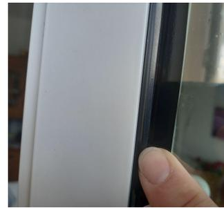
Commencez par le bord de la fenêtre. Retirez le liner d'une main et fixez le ruban d'étanchéité des bords de l'autre main, en partie sur le film de la fenêtre et en partie sur la vitre, pour obtenir un bon résultat d'étanchéité.
